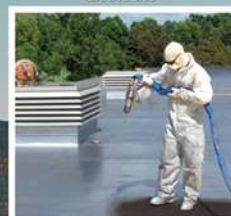
IMPERMEABILIZAÇÃO COM POLIUREIA
