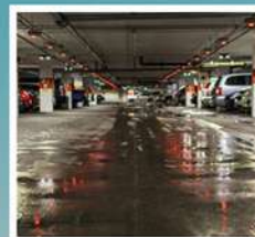
IMPERMEABILIZAÇÃO DE GARAGENS
